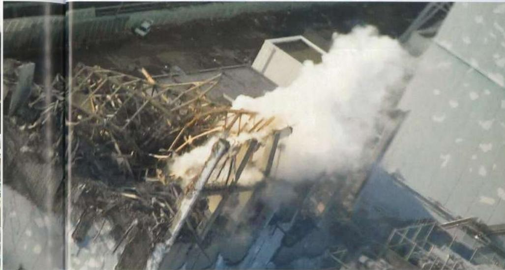
3月16日に上空から撮影された3号機の原子炉建屋。上部は原形をとどめず白煙が上がる
